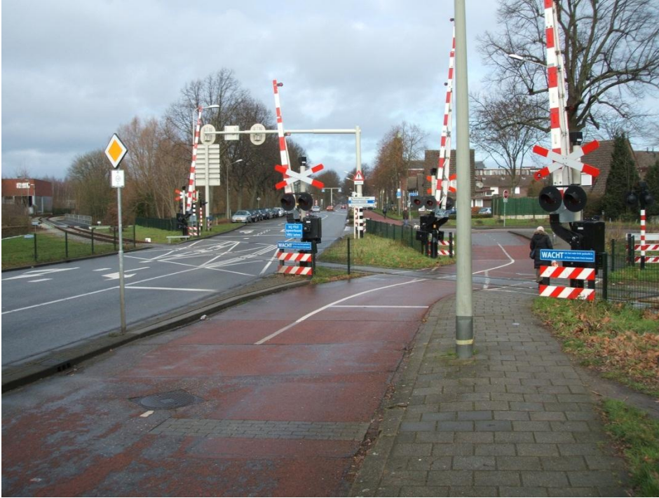
Foto 8 – Zuidzijde overweg Bosscherweg, lijncode 072, km 37.735.
